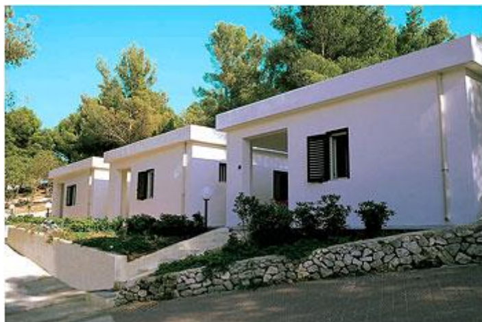
Villini trilocali muratura
