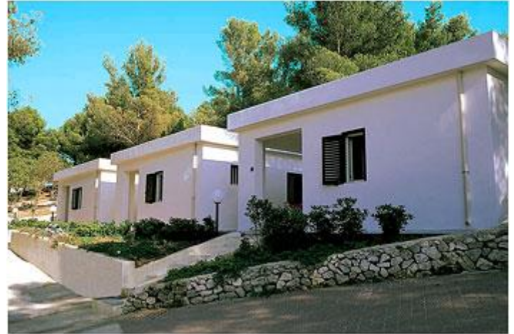
Villini trilocali in muratura
